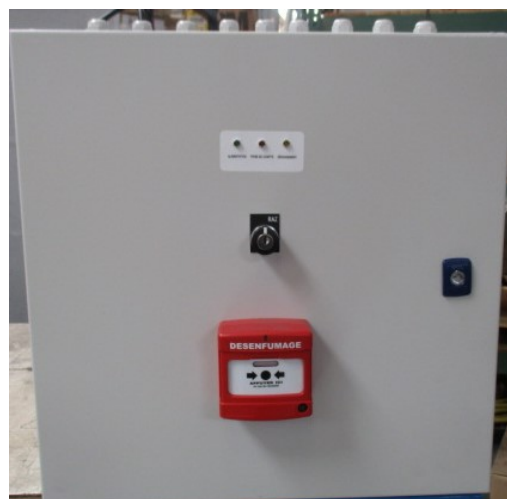
Vue extérieure du coffret de commande avec bouton de réarmement et organe de déclenchement manuel
